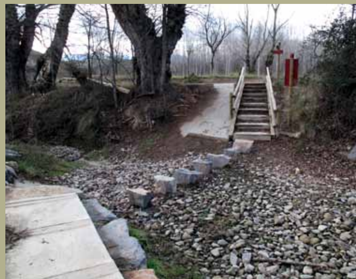
Acondicionamiento del sendero en un cruce de barranco
