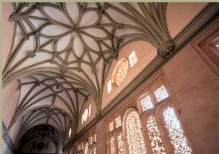
Bóvedas y celosías del claustro
