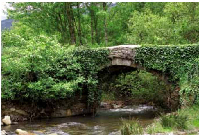
Puente sobre el Huecha
