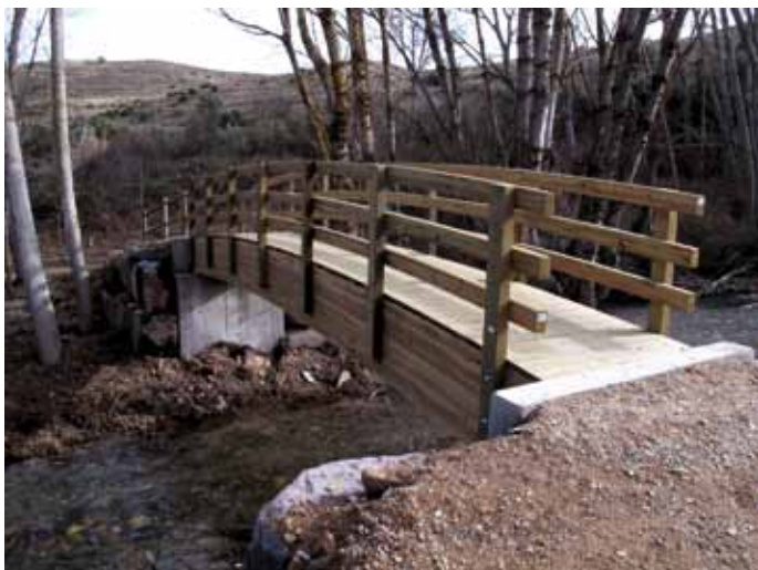
Pasarela sobre el Queiles que da acceso al sendero botánico
