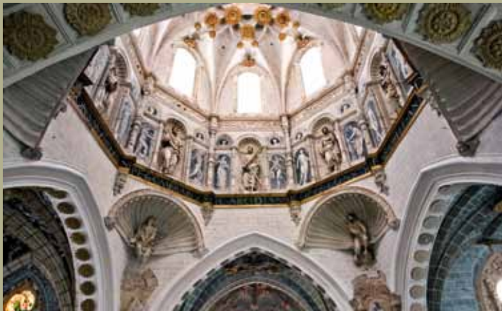
Interior del cimborrio
